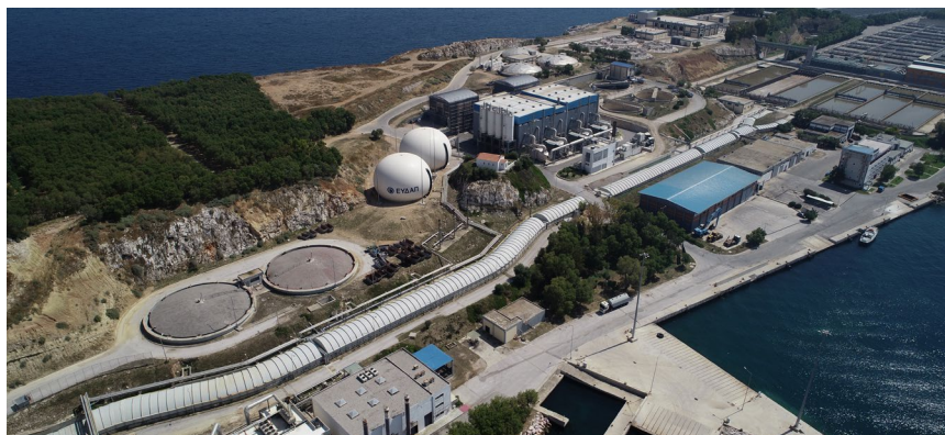
Το Κέντρο Επεξεργασίας Λυμάτων στην Ψυττάλεια (ΠΗΓΗ: ΕΥΔΑΠ)
