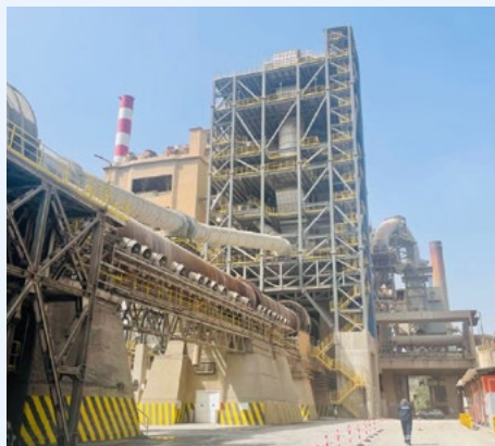
Η εγκατάσταση του προσβεστοποιητή (calciner)
