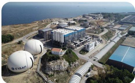
Στο ΚΕΛ Ψυτάλλειας όλη η ποσότητα βιοαερίου που παράγεται χρησιμοποιείται για τις ενεργειακές ανάγκες της εγκατάστασης. Πηγή: ΕΥΔΑΠ
